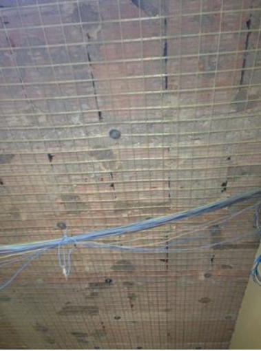
11. La rete in GFRP posata all'intradosso del solaio.
