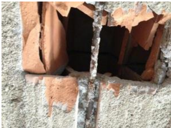
3,4. Dettagli dello stato di degrado degli elementi in laterizio che costituiscono i solai.
