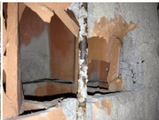
3,4. Dettagli dello stato di degrado degli elementi in laterizio che costituiscono i solai.
