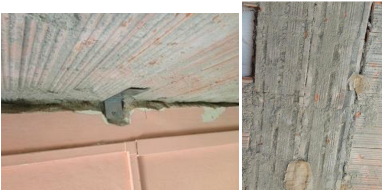
5,6,7,8. I solai predisposti per la posa della rete in GFRP.
